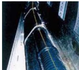
Рис. 5. Контроль температуры КЛ с помощью оптоволоконных датчиков
